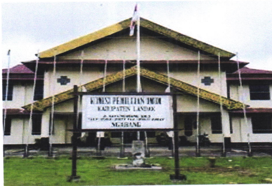
Gambar 1.24 Kantor KPU Kabupaten Landak Jalan Raya Pontianak-Ngabang Km.3 Ngabang
