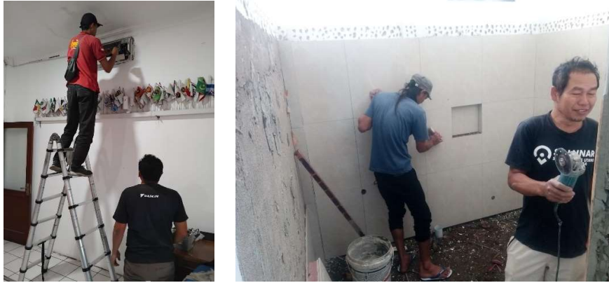
Gambar 11. Proses Renovasi Toilet dan Perbaikan AC di Ruang Pintar Pemilu (RPP)
